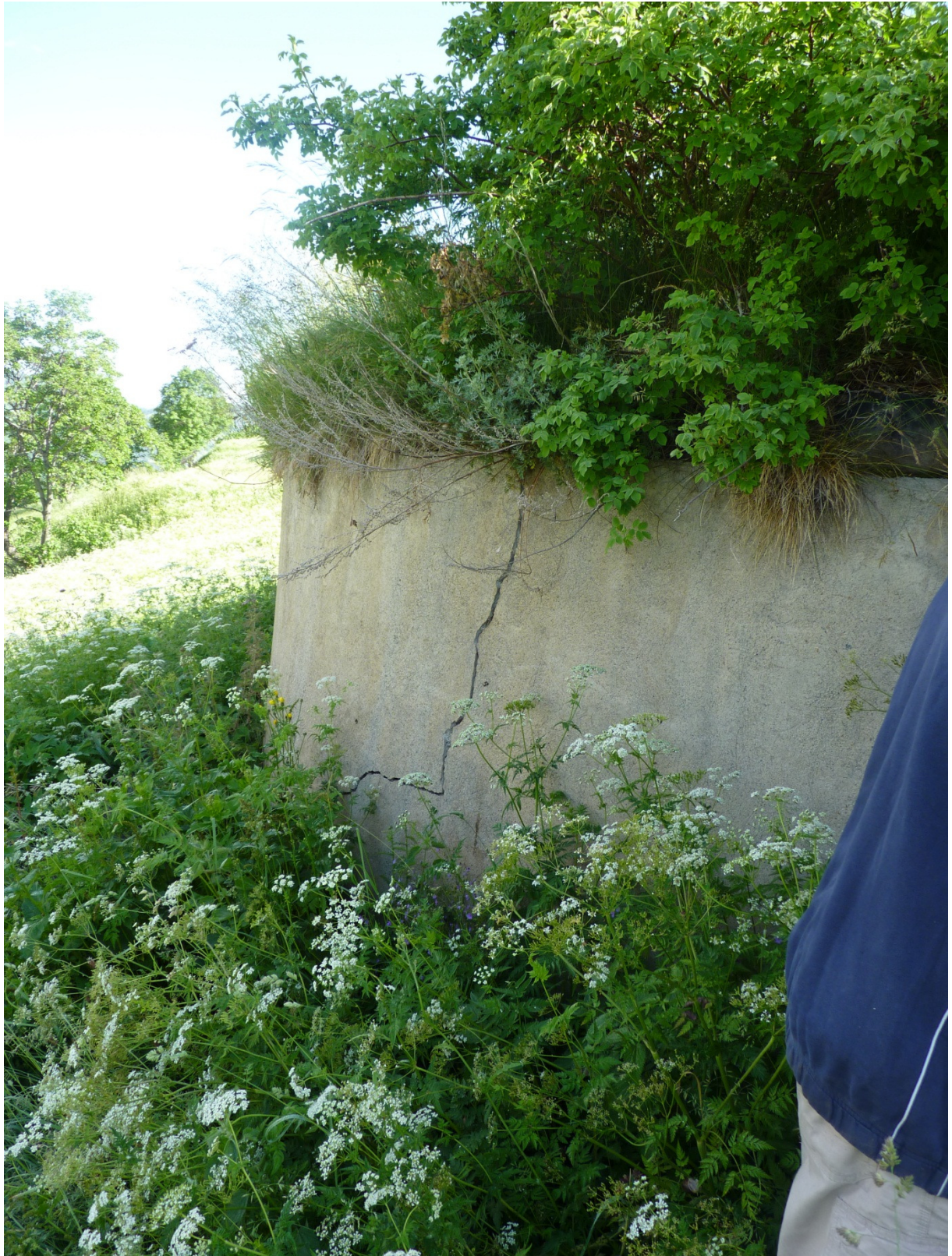
Photo 5 : Aperçu de l'extérieur de la cuve du réservoir du Col
